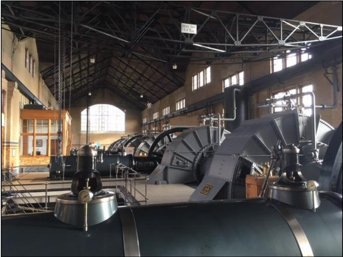
Turbines en pompen
